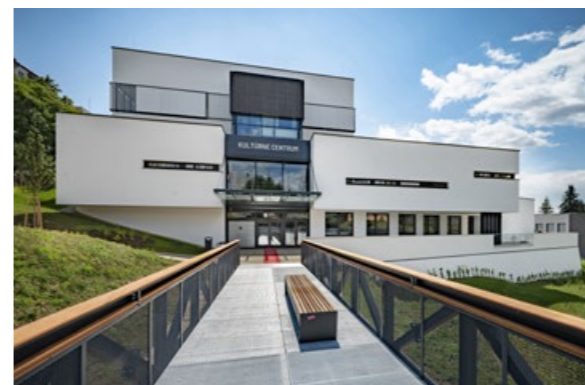
48 Modernizácia Kultúrneho centra REKONŠTRUKCIA
