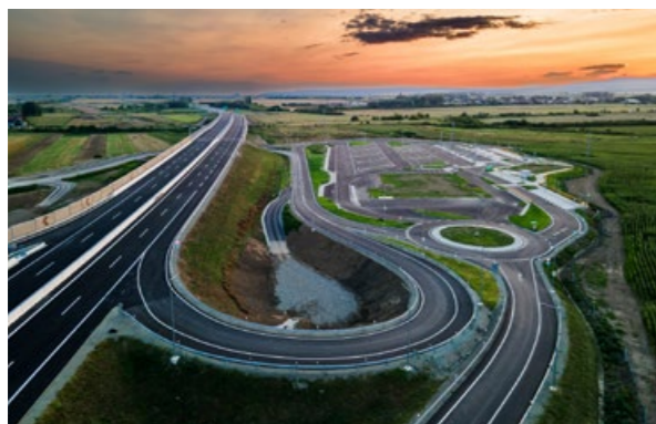
32 R2 Košice, Šaca – Košické Olšany, II. úsek NOVOSTAVBA
