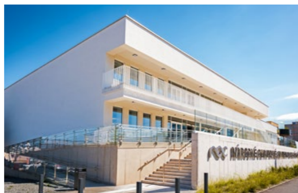
44 Národné olympijské centrum plaveckých športov / REKONŠTRUKCIA
