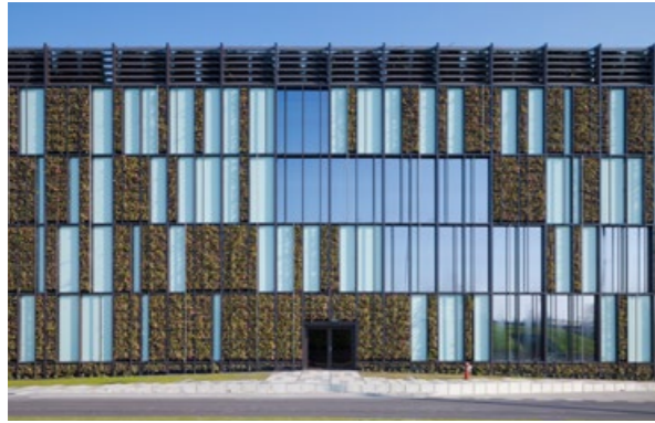
72 Rozšírenie nákupného centra AUPARK NOVOSTAVBA
