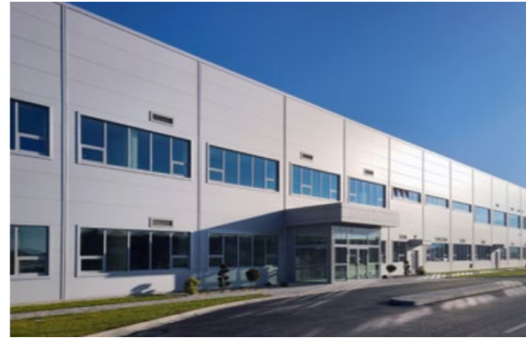
84 Výrobná hala PE system NOVOSTAVBA
