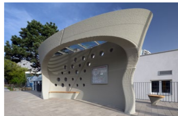
56 Zastávka mestskej hromadnej dopravy Lipského / NOVOSTAVBA
