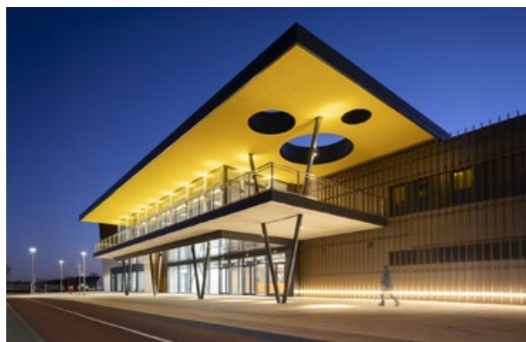
24 Šport Aréna NOVOSTAVBA
