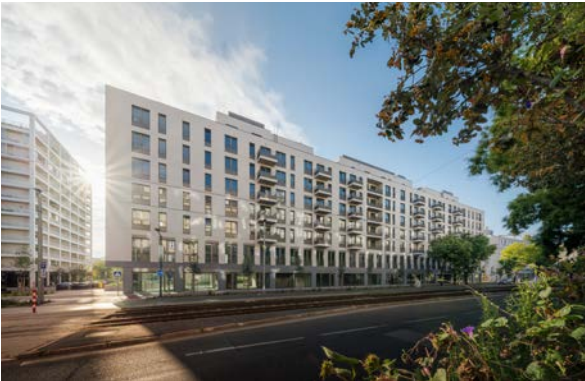
76 Rezidenčný projekt Pri Mýte III NOVOSTAVBA
