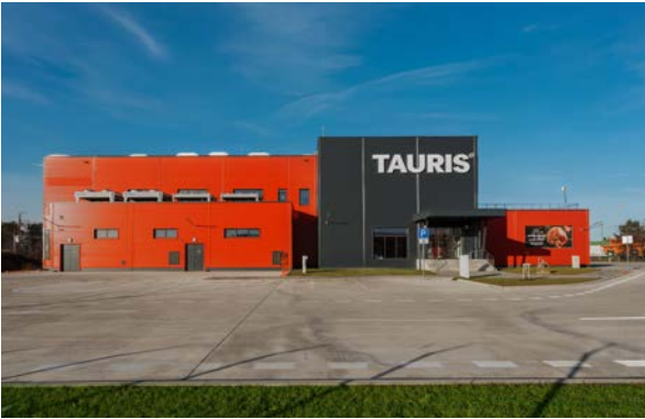
80 Centrálny sklad TAURIS Group NOVOSTAVBA
