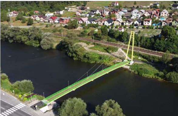
40 Cyklolávka cez rieku Váh NOVOSTAVBA
