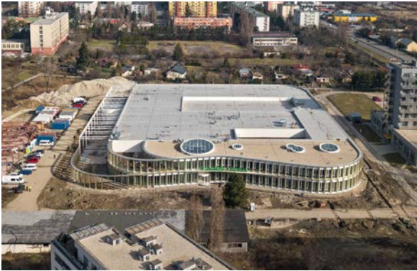
56 Výrobné a administratívne sídlo UNIMED NOVOSTAVBA
