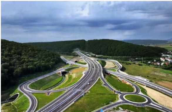
70 R4 Prešov, severný obchvat, I. etapa NOVOSTAVBA
