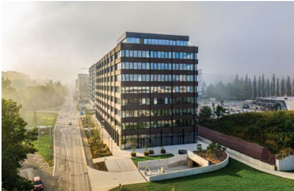
62 NORDCITY Obchodná NOVOSTAVBA
