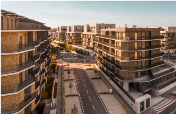
58 Bytové domy UNIQ Slnečnice, zóna 4 NOVOSTAVBA
