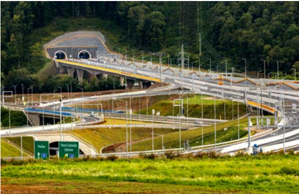
R4 Prešov, severný obchvat, I. etapa Cena za použitie progresívnych stavebných výrobkov a inovatívnych postupov výstavby
