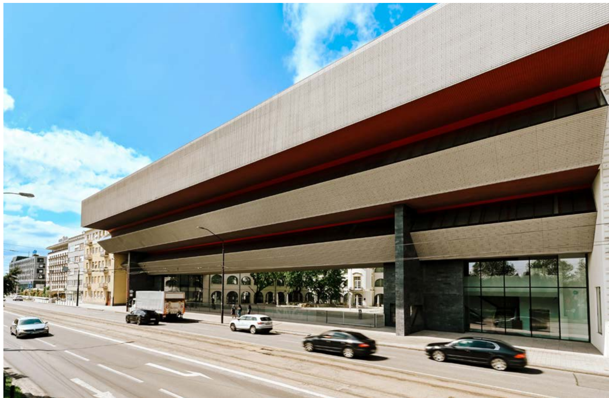
Rekonštrukcia a dostavba Slovenskej národnej galérie v Bratislave
