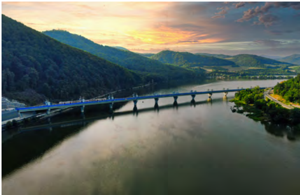
66 MODERNIZÁCIA TRATE PÚCHOV – ŽILINA, I. ETAPA NOVOSTAVBA
