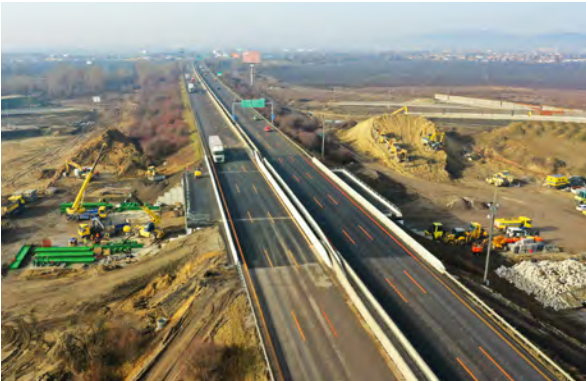
70 DIAĽNICA D1 BRATISLAVA - TRIBLAVINA, MOST D1/D4 NOVOSTAVBA
