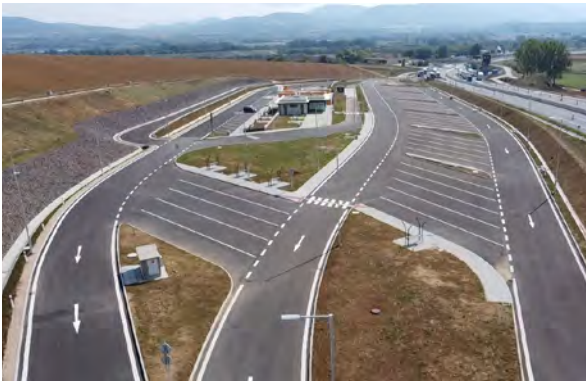
62 R4 KOŠICE – MILHOŠ, ODPOČÍVADLO NOVOSTAVBA
