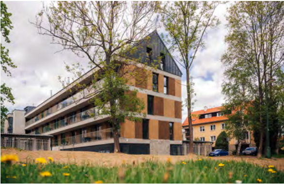
30 BYTOVÝ DOM POD LEŠOM NOVOSTAVBA
