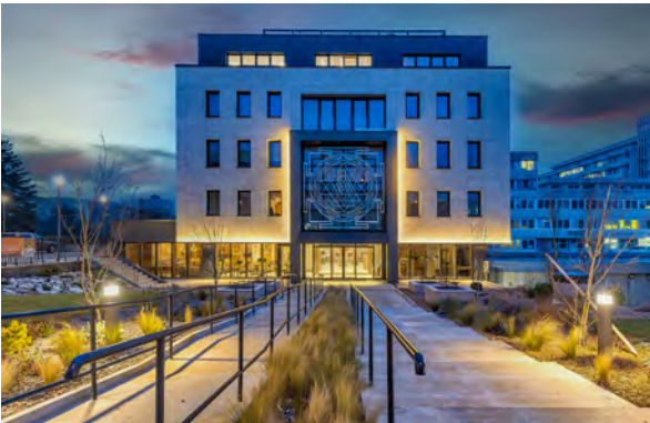
38 UBYTOVNĽA PRE ZAMESTNANCOV NEMOCNICE BORY NOVOSTAVBA
