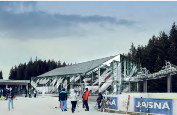
74 LANOVÁ DRÁHA JASNÁ, BIELA PÚŤ – PRIEHYBA NOVOSTAVBA
